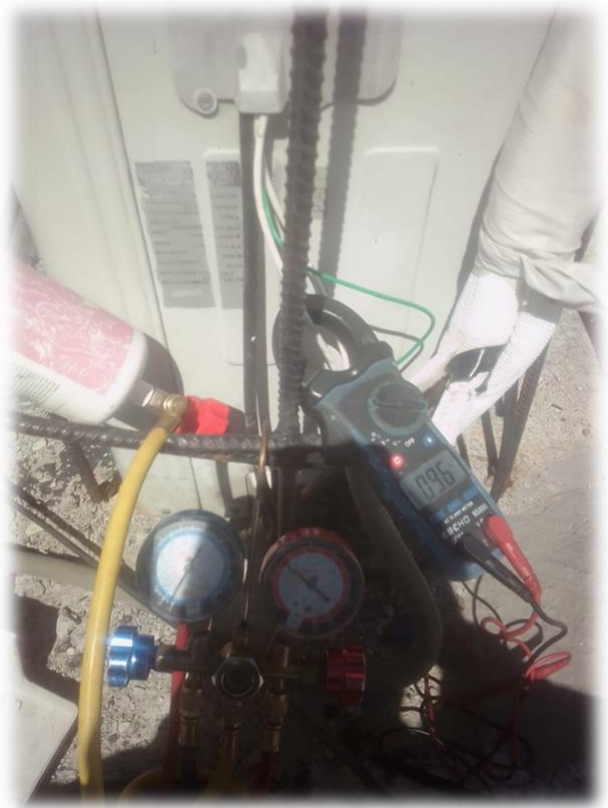
En esta otra imagen se puede ver como el amperaje y la presión de gas refrigerante aumentaron llegando a lo requerido luego de corregir la fuga de gas refrigerante y de completar la carga de gas refrigerante R-410A.
