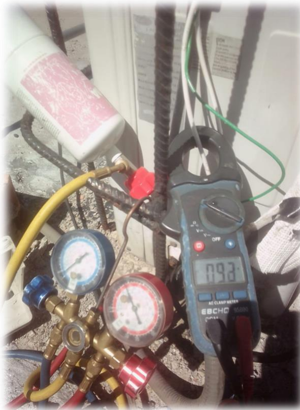
En esta otra imagen se puede ver como el amperaje y la presión de gas refrigerante aumentaron llegando a lo requerido luego de corregir la fuga de gas refrigerante y de completar la carga de gas refrigerante R-410A.
