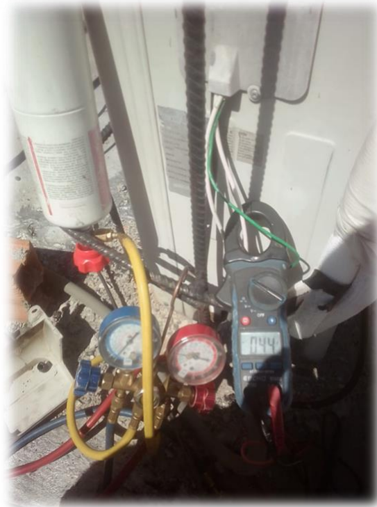
En esta imagen se puede apreciar que el amperaje del equipo y la presión de gas refrigerante están por debajo de lo requerido
